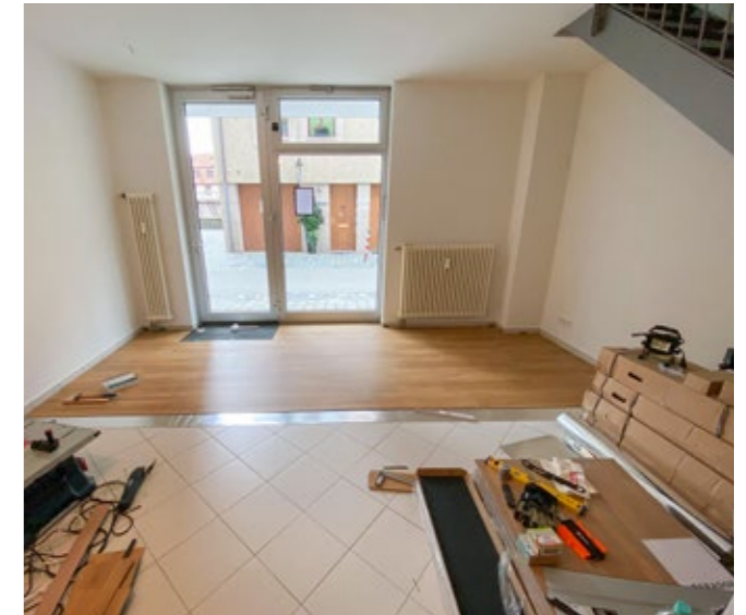
WÄHREND DER RENOVIERUNG
