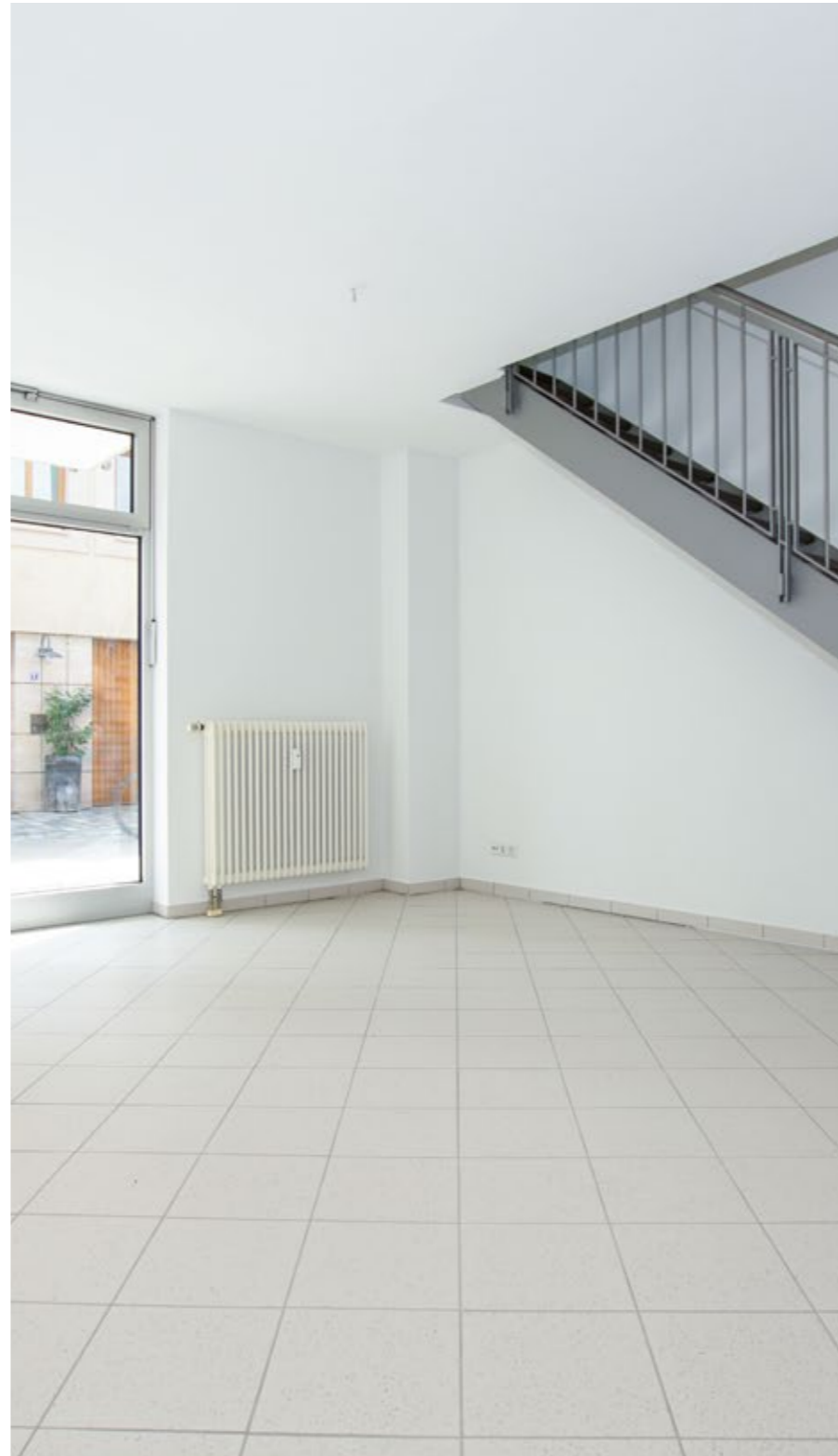
UNSER BÜRO VORHER (MIT FLIESEN)
