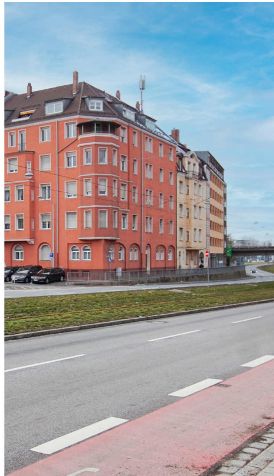
EIGENTUMSWOHNUNG IN NÜRNBERG-WETZENDORF
